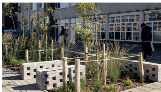
Exemple de réemploi et transformation de dalles béton en bancs et assises
