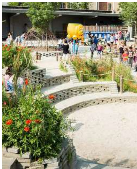
_ Gradins en dalles récupérées
